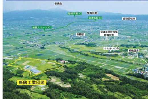
各種測定機・警報機の製造工場 新鶴工業団地
