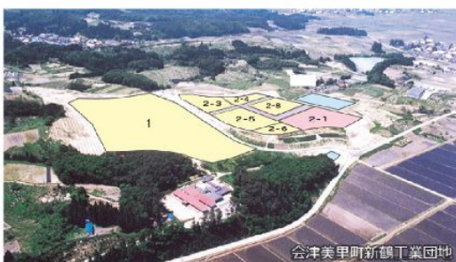
各種測定機・警報機の製造工場 新鶴工業団地
