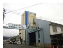
本社(福島県 会津若松市)
