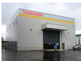
塩川第2工場(加工工場) 面積 492㎡ 高さ 12.8m
