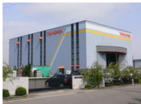
塩川第1工場(組立工場) 面積 755㎡ 高さ 12.8m
